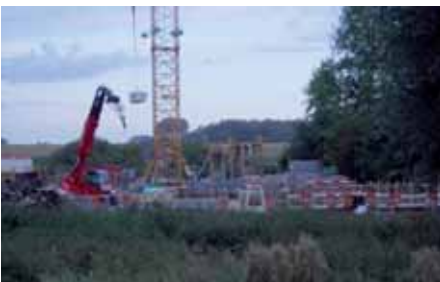
Construction de la STEP de Bomal
