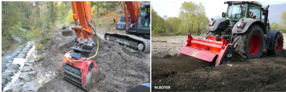
Concassage de terres contaminées sur place au moyen d'un godet-concasseur ou sur une aire spécifique avec un broyeur de pierres - Photos : ©Mireille Boyer, CCEAU
