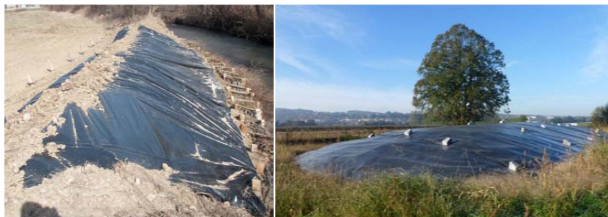
Bâchage de la zone traitée sur place ou stockage sous bâche des terres concassées
