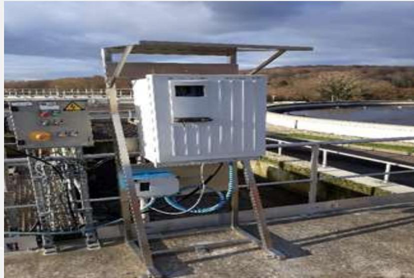
L'analyseur de phosphate automatique permet d'adapter en temps réel le dosage de chlorure ferrique à la charge de phosphore.
