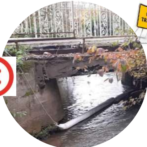
Position incorrecte des boudins absorbants, Trop tendu et !!! ne pas soulever les extrémités
