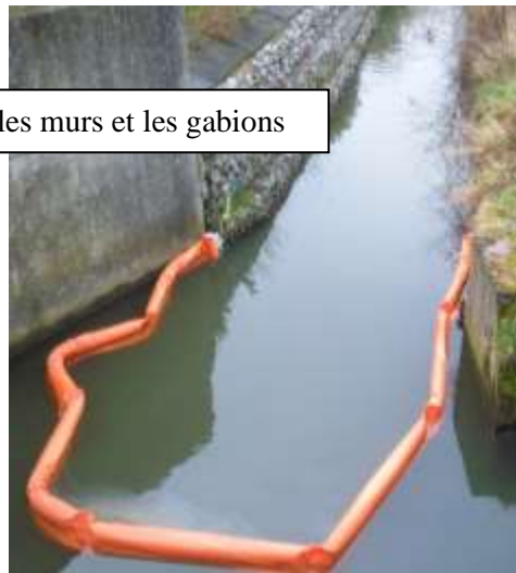
En aval des zonings prévoir des ancrages permanents. Dans ce cas particulier, un barrage de confinement peut être utile afin de confiner les graisses en cas d'accident.
