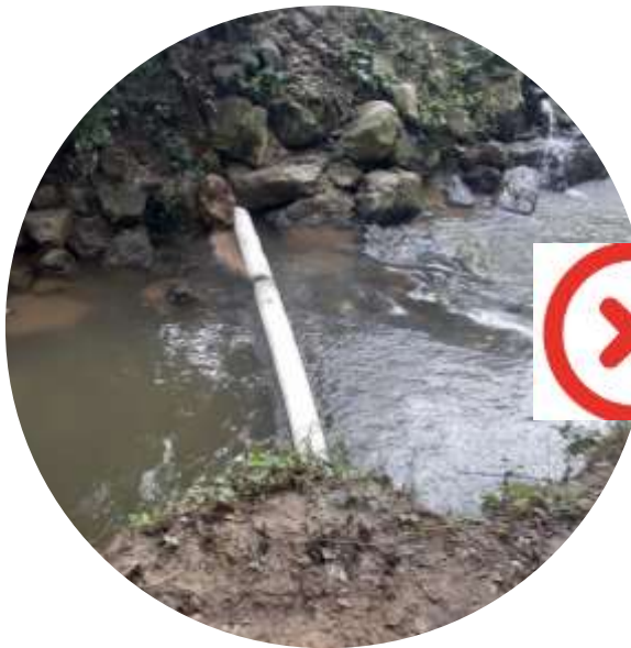
Position incorrecte des boudins absorbants, Trop tendu et !!! ne pas soulever les extrémités
