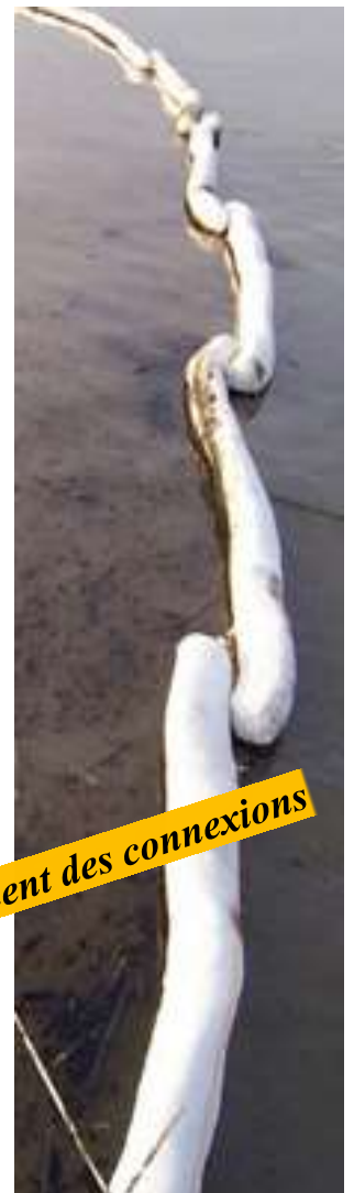
Position correcte des boudins absorbants, en arc et éléments bien assemblés
