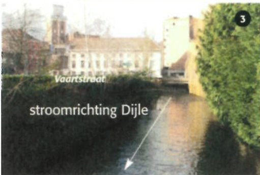
Foto 3 toont de huidige situatie. De Dijle komt aangestroomd vanonder de brug in de Vaartstraat vanuit de afgebroken Artois-site met links in de verte de watertoren en het gebouw Zeelandt, allebei beschermd. Op tekening 2 zien we vanuit hetzelfde gezichtspunt hoe het daarna zou kunnen worden.
