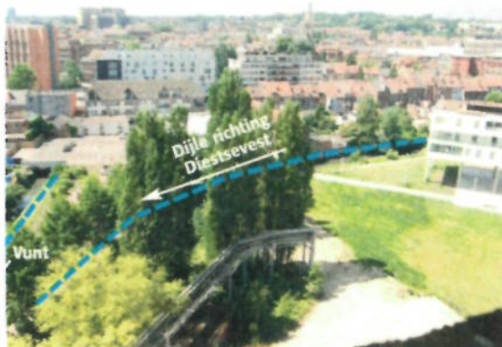
Vanop het hoogste dak van de thermische centrale (buiten-zicht rechts hiernaast) zien we de in 2014 nog braakliggende Tweewaters-terreinen. Linksboven woontorens van Sint-Maartensdal, in de verte de Sint-Pietersklinieken, uiterst rechts een stukje van de afgewerkte "balk van Beel".
