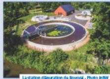
La station d'épuration de Bousval - Photo INW
