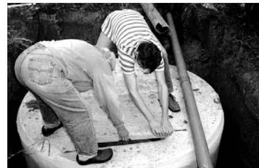
Installation d'une station d'épuration individuelle Photo: Mommaerts - Bossicart
