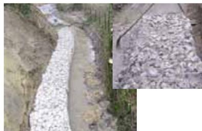
La **pose de gabions** est une opération de stabilisation des berges réalisée à l'aide d'un treillis en acier à mailles remplis de blocs de pierres. Ces treillis sont mis au pied des berges.
