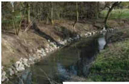
**L'enrochement** est un ouvrage de stabilisation de berges réalisé à l'aide de gros blocs de pierres (moellons bruts) à placer au pied ou en protection de berges.
