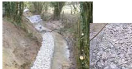
La **pose de gabions** est une opération de stabilisation des berges réalisée à l'aide d'un treillis en acier à mailles remplis de blocs de pierres. Ces treillis sont mis au pied des berges. Il existe d'autres techniques de consolidation des berges comme par exemple le tunage et l'enrochement.
